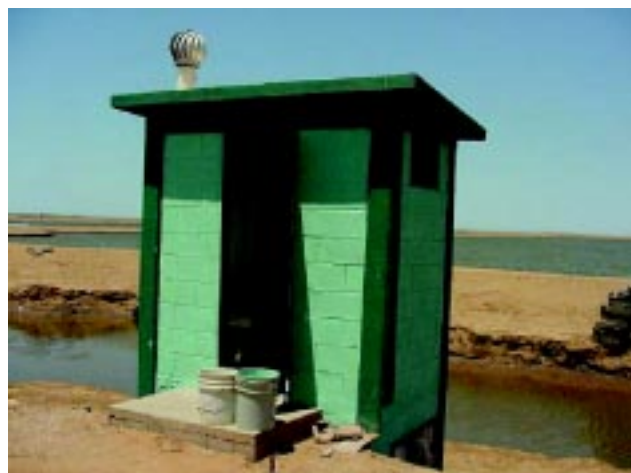
Figura 3 Letrina en una granja de camarón. El desagüe no debe de dar al cuerpo de agua.
