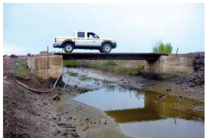
Figura 19. Puente de una vía de acceso ubicado sobre un canal en una granja camaronera, para permitir el flujo natural de las aguas de drenaje según la dinámica de las mareas. Foto cortesía del Lic. M. De León.
