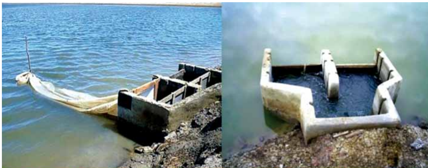
Figura 52a. Estructuras de entrada (izquierda) y de salida (derecha) en un estanque de cultivo de una granja camaronera, en las cuales se mantienen filtros de malla, bolso y entablado para evitar el ingreso de organismos foráneos y la fuga de camarones durante el ciclo de producción. Fotos cortesía del Ing. C. Lara.
