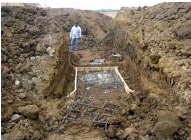
Figura 15b. Corte estratégico en un muro de un estanque durante la construcción de una granja camaronera, en el cual se está construyendo una estructura de entrada. Foto cortesía del Dr. J. Cuéllar-Anjel.
