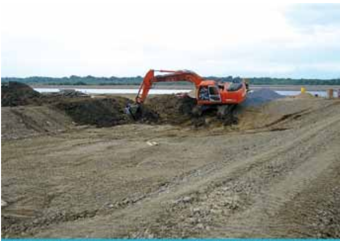
Figura 13a. Proceso de construcción de estanques en una granja camaronera, en una zona de albina con alto contenido de arcilla y limo (textura adecuada) que permite la buena compactación de los muros. Foto cortesía del Dr. J. Cuéllar-Anjel.
