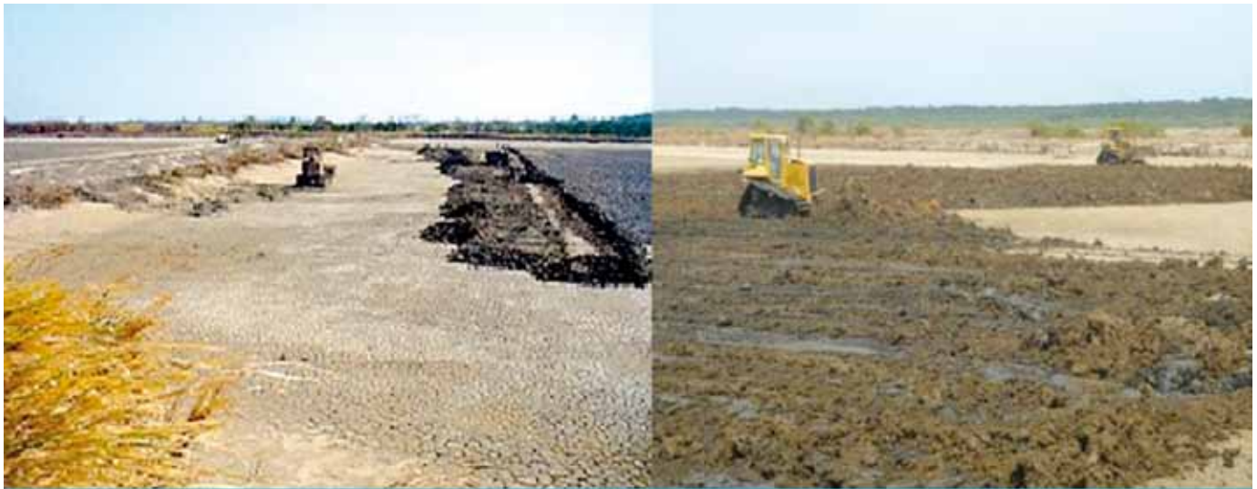
Figura 30a. Labores de eliminación de sedimento y restablecimiento de canales de cosecha del fondo de estanques camaroneros, así como conformación de los muros. Fotos cortesía del Lic. M. De León.
